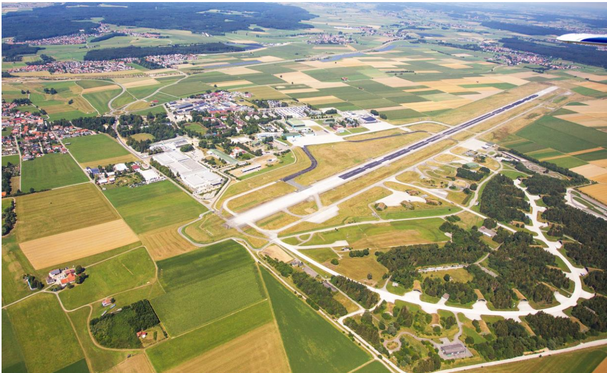
Die Ansicht der Shelterschleife vor Beginn der Umbauarbeiten.
